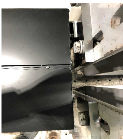
写真5.3・3 試験前状況 マリオン上部
