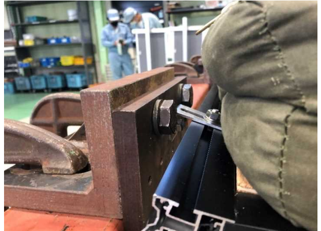
写真5.1・14 ブラケットの状態 縦柱上部
