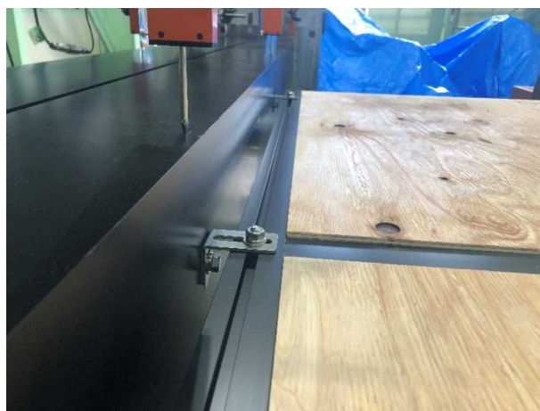
写真5.1.4 ブラケットの状態 ボード面に構造用合板を設置。
