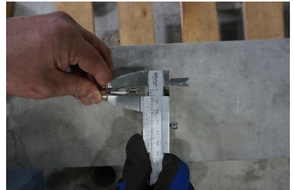
写真5.1・4 試験前状況 アンカーボルト
