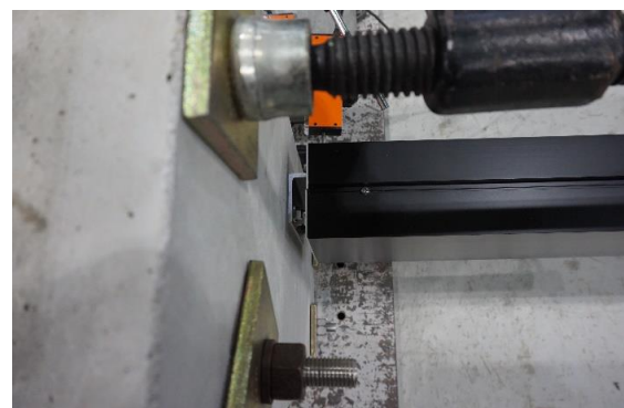
写真5.3・16 2,950[N/本]荷重除荷後の試験体状況 マリオン上部
