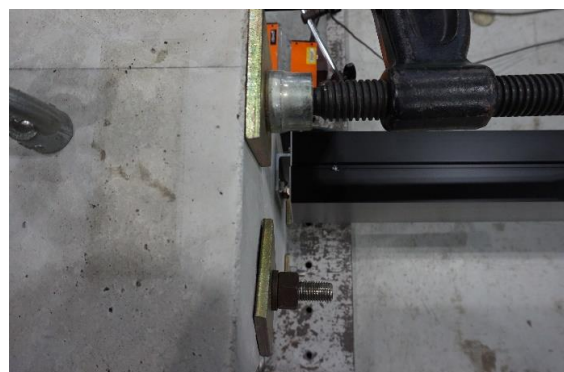
写真5.3・4 試験前状況 マリオン上部
