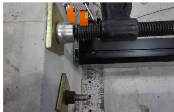
写真5.3・24 4,500[N/本]荷重除荷後の試験体状況 マリオン上部
